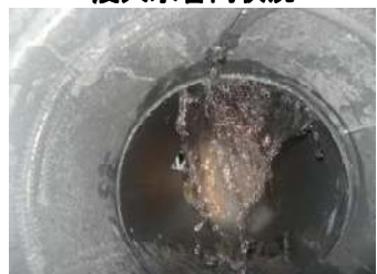
軸方向クラック・ 浸入水管内状況
