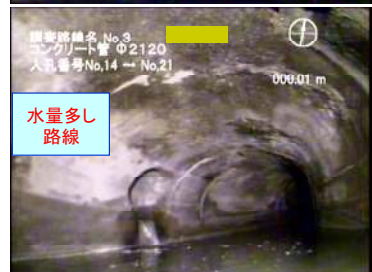
「ズームロボ」を搭載で改良 撮影距離110m 蛇行状況確認
