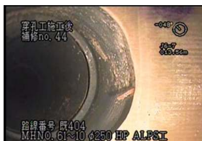
ALPS 穿孔状況
