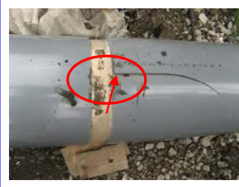
隙間部破壊 上部
