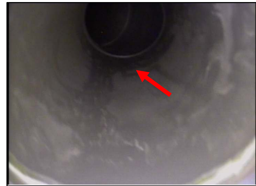
支管内部符合部確認状況
