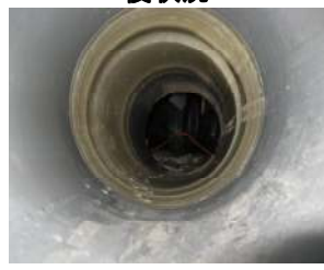
止水・補修施工 後状況
