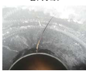
軸方向クラック 管内状況
