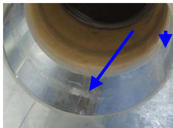
①. 水膨張ゴム装着 止水機能有
