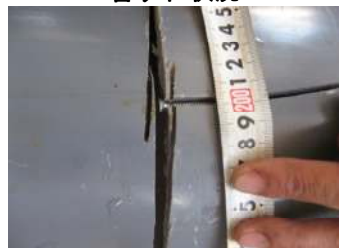
軸方向クラック 管ずれ状況
