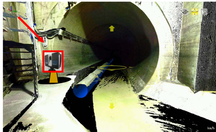
人孔左壁に測量器を設置して測量
