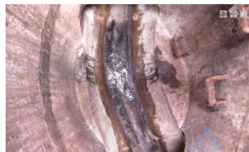
管底から管口管壁状況と管底部、管口内部
