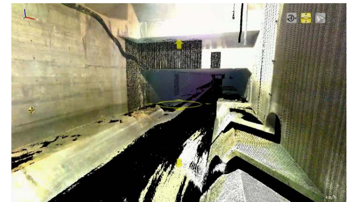
施設上流管口形状写真
