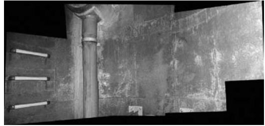
人孔中間部の連続写真
