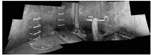
人孔底部の連続写真
